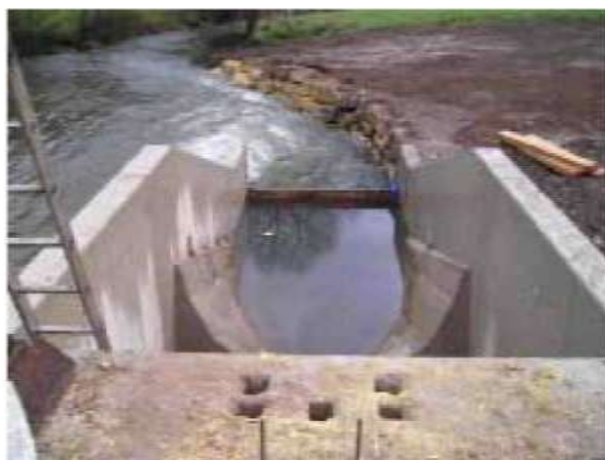
Costruzione al grezzo con presagomatura
