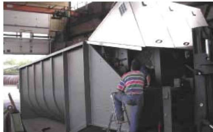
Messa in opera di una vite idraulica compatta
